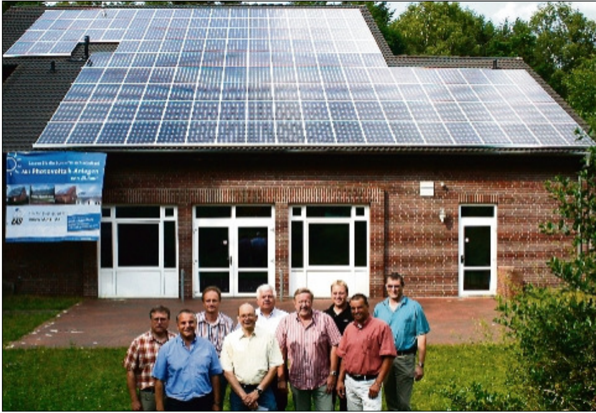
Begutachteten gestern die erste Bürger-Photovoltaikanlage in der Samtgemeinde Harpstedt – v.l.: Hans-Jürgen Wachendorf (E.ON Avacon), Rainer Bohl und Jochen Schlichter (I.D.-Bau-Geschäftsführer), Reinhard Wixforth (Vorstandsvorsitzender der Betreiber-GbR), Klaus Stark (im Vorstand der Betreiber-GbR), Walter Raem (Kirchseelter Bürgermeister und im Vorstand der Betreiber-GbR), Ingo Evers (Elektro Evers), Ingo Fichter (Allgemeiner Vertreter des Samtgemeindebürgermeisters) und Klaus Grubert (designierter Ortsbrandmeister). Foto: boh
